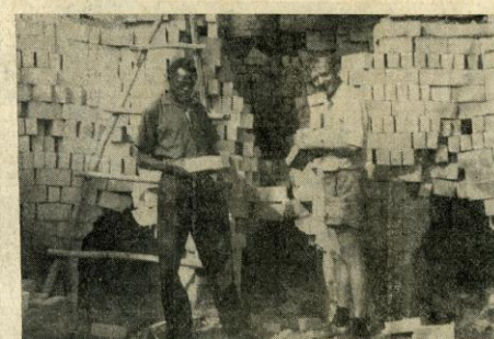
Gerhard Merschmeyer mit einem seiner schwarzen Helfer prüfen den Besatz in einem Feldbrandofen.
